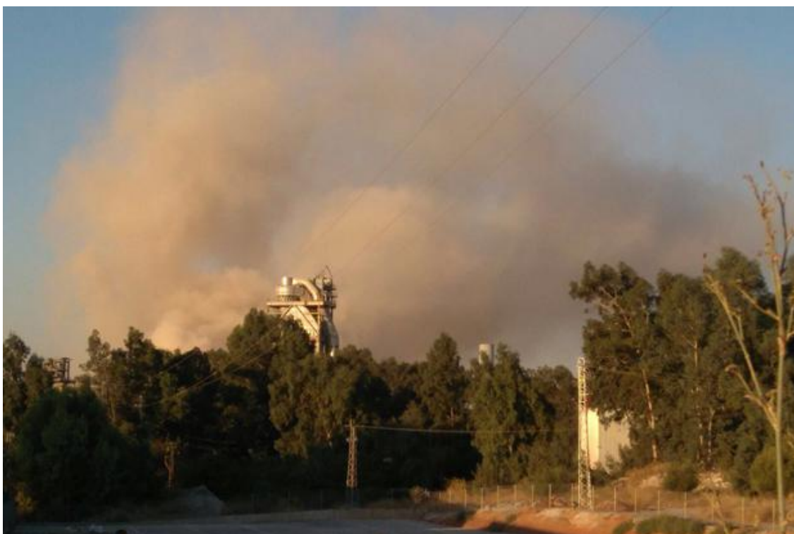
Incidente en la cementera COSMOS producido el 10 de septiembre de 2016 (Foto: CORDÓPOLIS)
