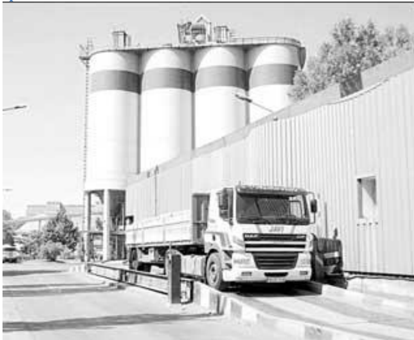
Instalaciones de la cementera de Córdoba, situadas en el casco urbano de la ciudad. Foto: PATRICIA CACHINERO
